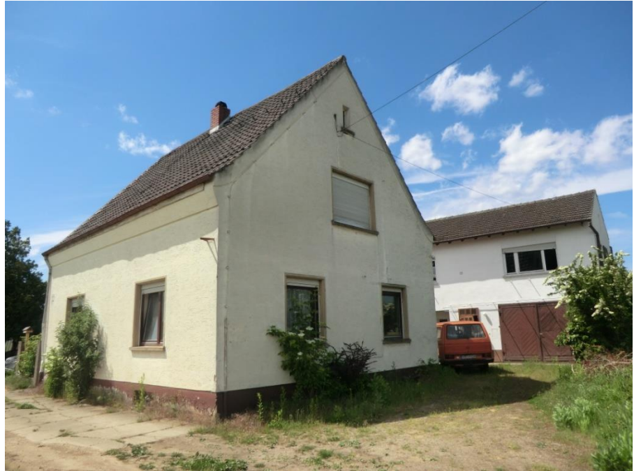
Abbildung 13 Gebäude im Norden (Bestand)
