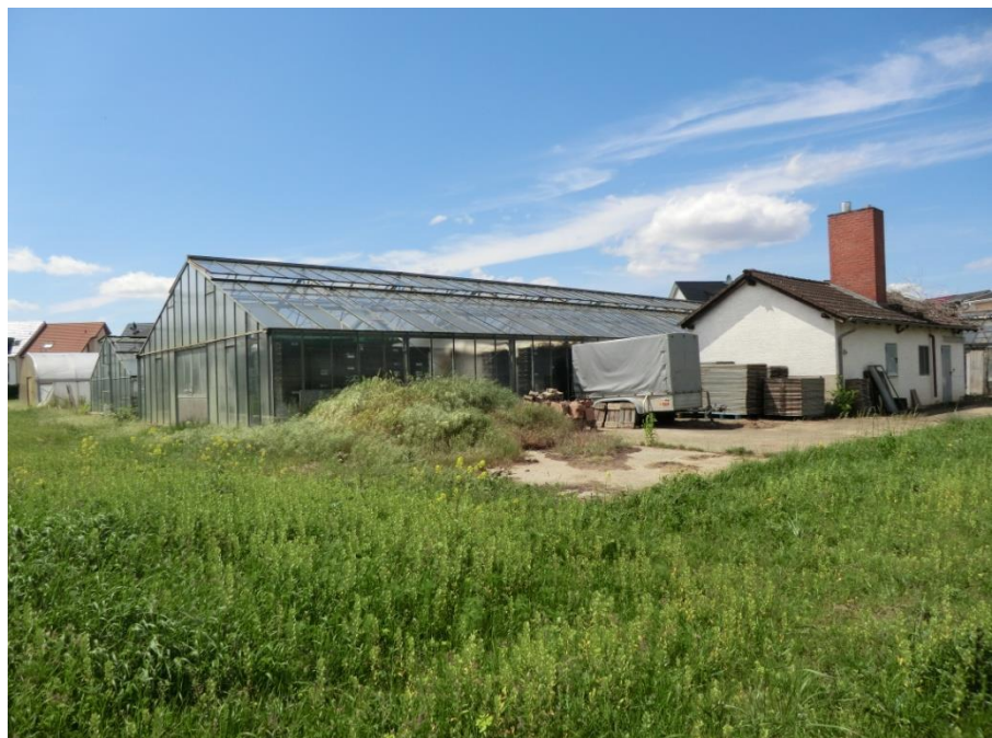
Abbildung 10 Gewächshaus und Ge- bäude (Heizraum) im Nordwesten
