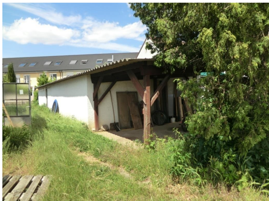
Abbildung 12 Schuppen im Norden (Bestand)
