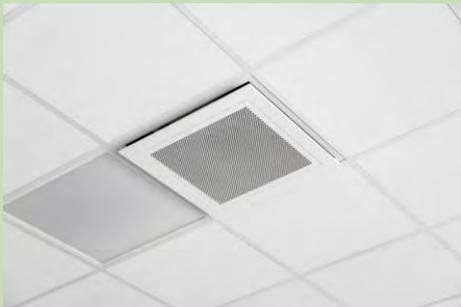
Abbildung 25: Decken-Umluft-Gerät (Fancoil) zum Einbau in Rasterdecken
