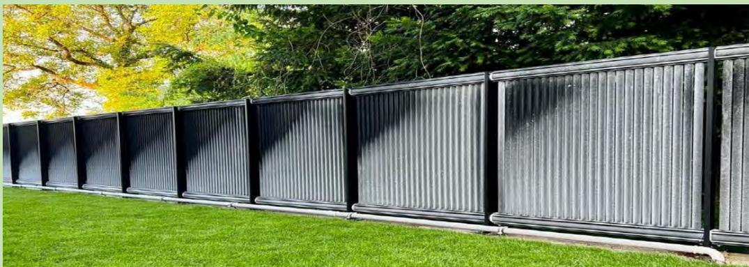
Abbildung 34: Ein Solar-Luft Absorber als „Energiezaun“ ausgeführt
